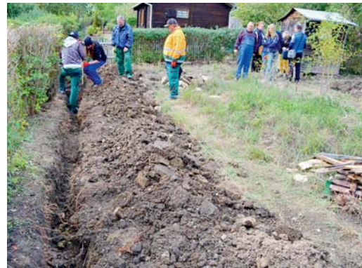
Für die Gartenlaube im künftigen Therapiegarten wurde im Herbst eine neue Stromleitung verlegt.
