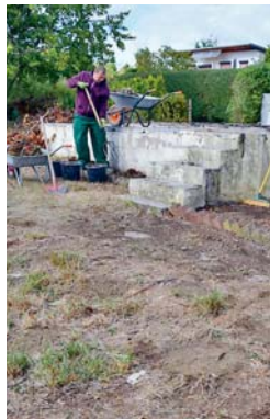
Auf dieses Fundament soll ein Palettenhaus kommen.
